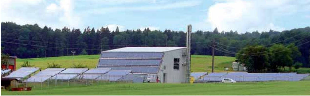
**BILD 9:** Heizwerk des Bioenergiedorfs Büsingen mit 1.090 m<sup>2</sup> Vakuumröhrenkollektoren und einem Biomassekessel.
