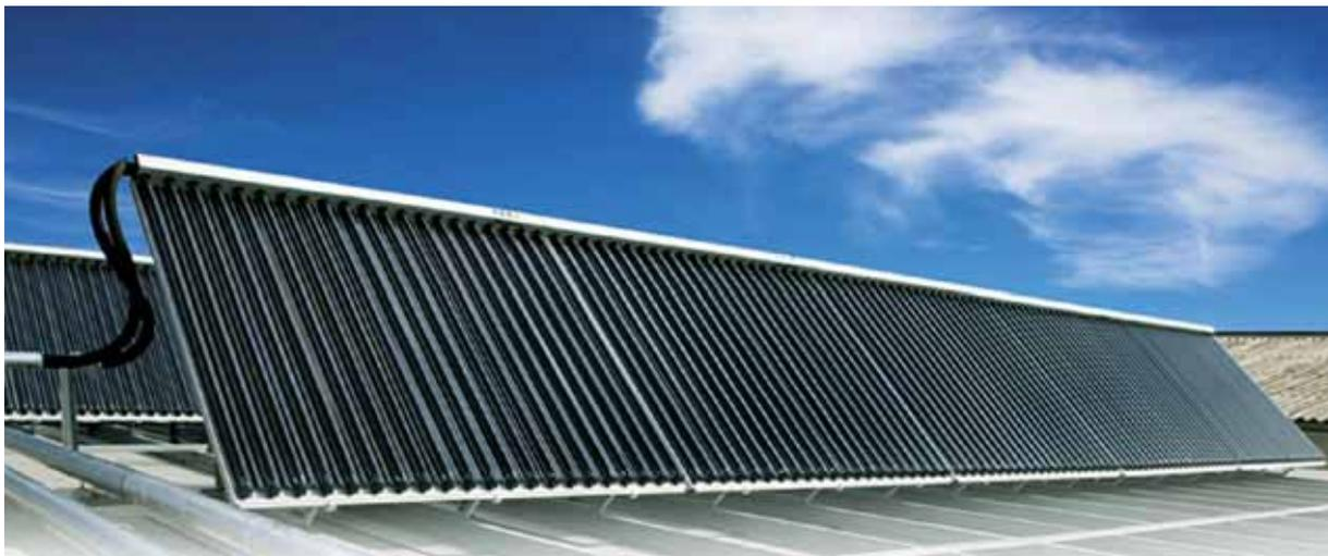
**BILD 16:** Vakuumröhrenkollektoren für solarthermische Großanlagen.
